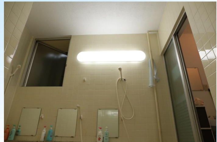
2階風呂天井塗装
