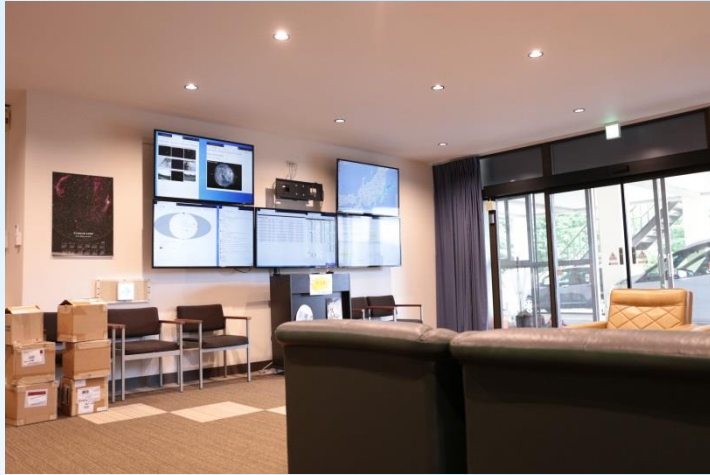
本館ロビー改修
