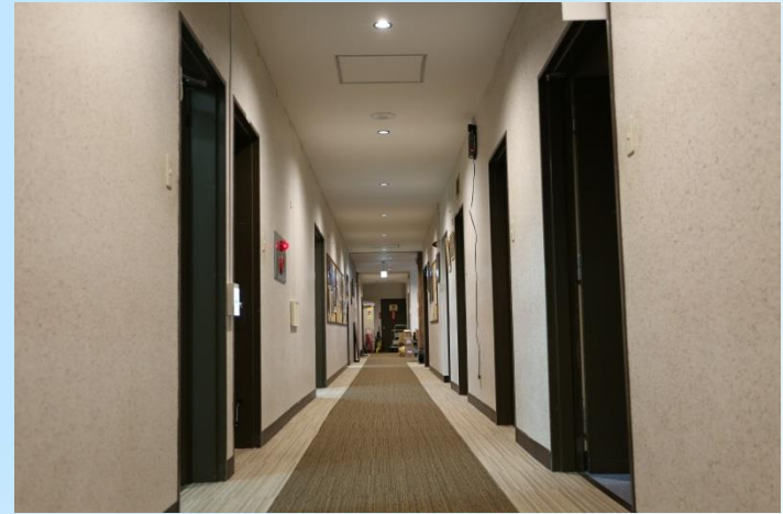
本館廊下天井改修
