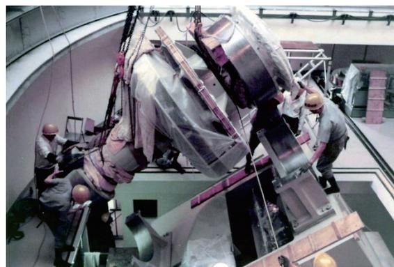
図9. 極軸の取り付け
