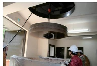
図3. ミラーをクレーンで釣り、運搬箱へ
