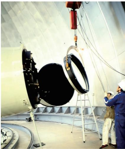
**プリズム装填作業:** 総重量約400kgのプリズムユニットは、ドーム付属のクレーンで吊り上げ、補正板手前のプリズム回転リングに取り付ける。リングは90°刻みで回転させることが可能。
