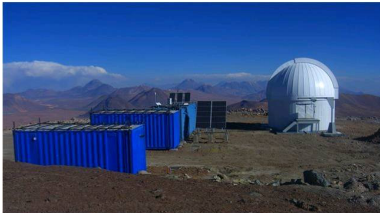
図 5.17: 山頂写真. コンテナは奥から観測コンテナ, 倉庫コンテナ, 発電機コンテナである.
